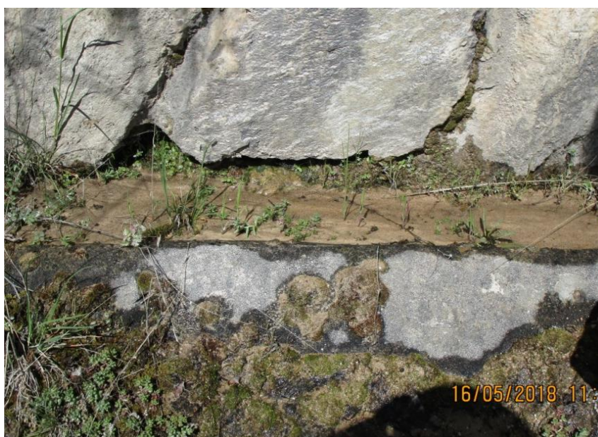
Figura 66.- Fotografía de detalle del proceso de arenización entre los mampuestos.
