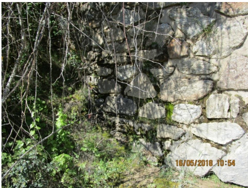
Figura 65.- Fotografía de detalle de la base de la zona inferior a la Grieta nº 1, en la zona de contacto del muro con el terreno.
