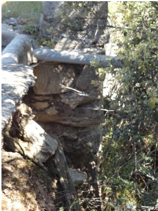
Figura 35.- Detalle de los mampuestos del muro de mampostería, con juntas recebadas de mortero parcialmente.
