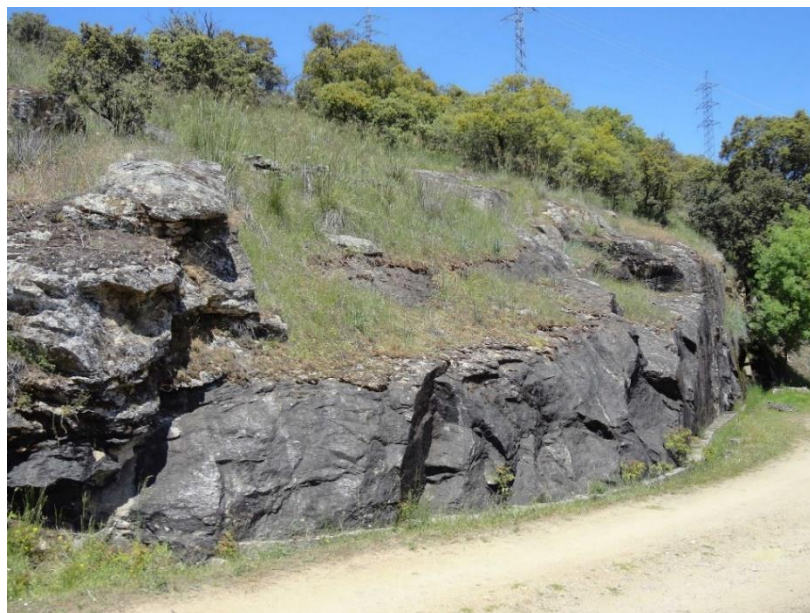
Figura 98.- Fotografía de detalle del talud de cabecera de la plataforma, que sería necesario excavar y retranquear para ampliar la plataforma de trabajo de la grúa.
