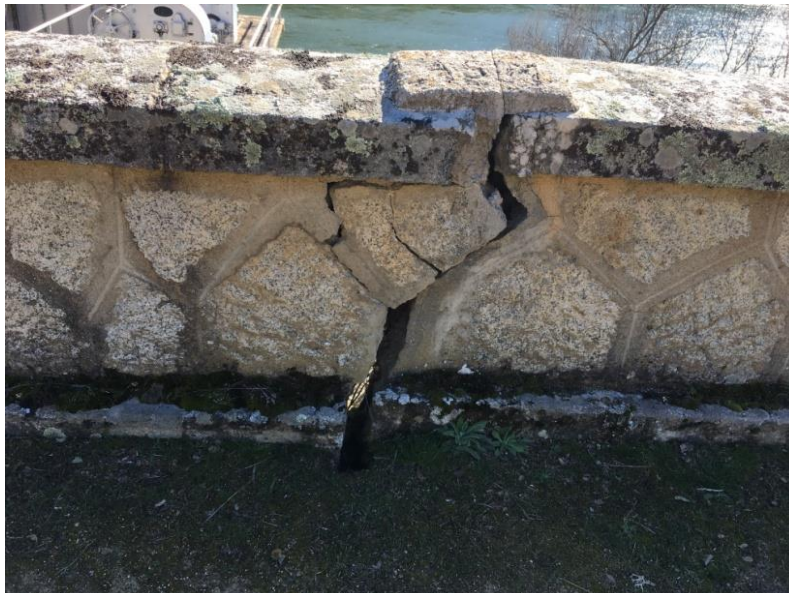
Figura 12.- Fotografía de la grieta 1 en el pretil del muro desde la plataforma.
