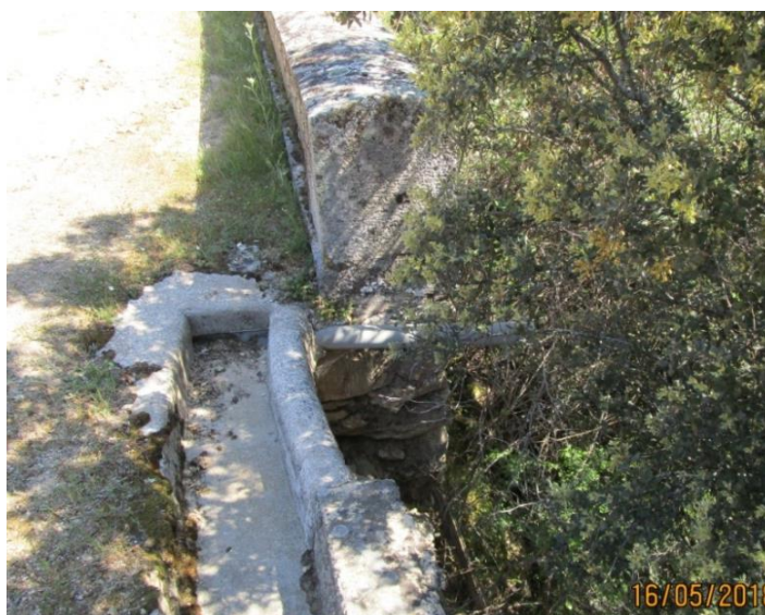
Figura 62.- Fotografía de detalle de la terminación de la cuneta y tubo de desagüe con reducida longitud.
