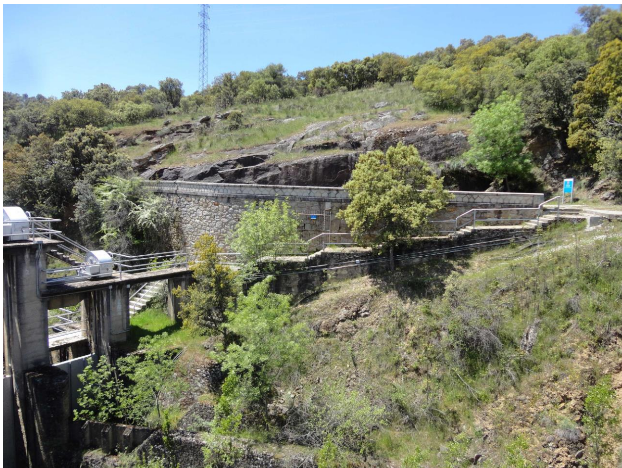
Figura 33.- Fotografía general del muro de mampostería, plataforma y talud en roca superior, así como del apoyo en roca en la base.
