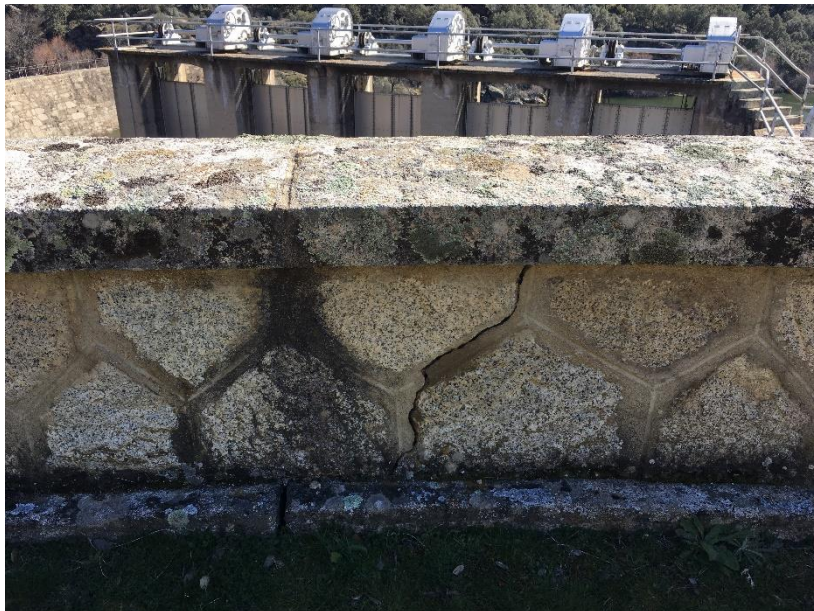
Figura 16.- Fotografía de la grieta 3 en el pretil del muro realizada desde la plataforma.
