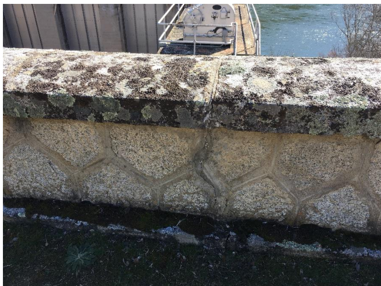
Figura 14.- Fotografía de la grieta 2 en el pretil del muro realizada desde la plataforma.
