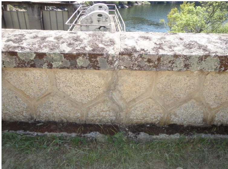
Figura 41.- Fotografía de la grieta nº 2, desde la plataforma.
