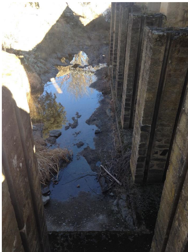
Figura 20.- Canal de descarga sin agua
