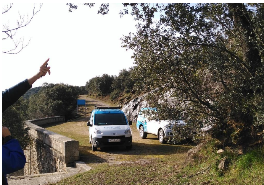
Figura 7.- Plataforma en estribo derecho del azud, sostenida por muro de mampostería
