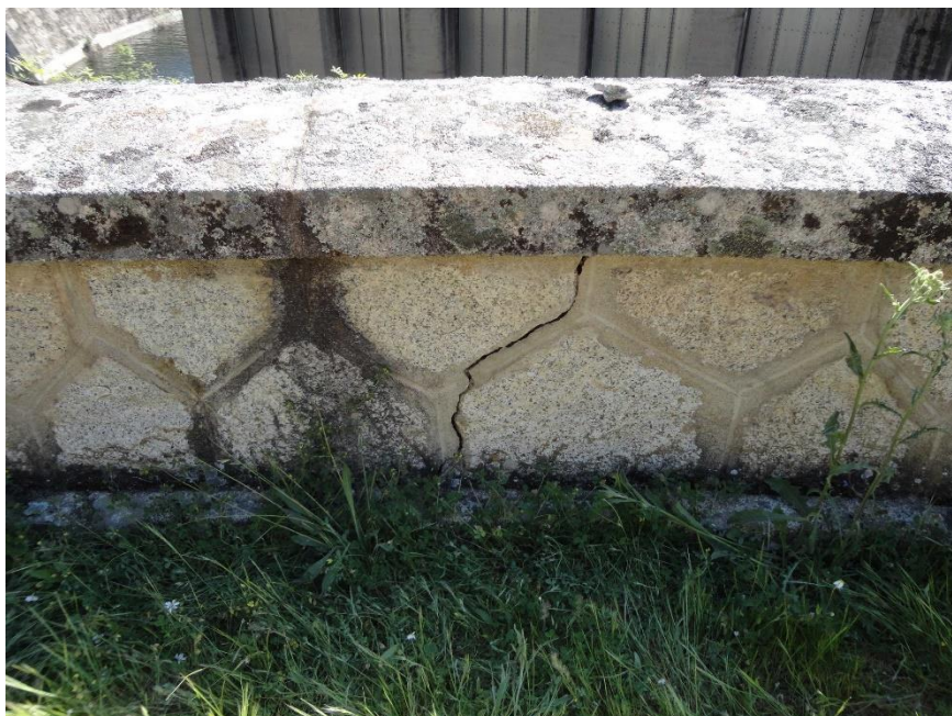
Figura 43.- Fotografía de la grieta nº 3, desde la plataforma.
