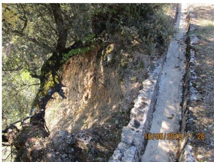
Figura 61.- Fotografía de detalle de la erosión bajo la cuneta.
