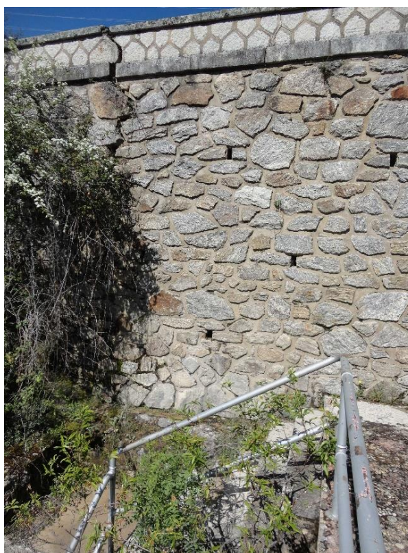
Figura 42.- Fotografía de la incipiente grieta nº 2, desde la zona inferior del pie del talud-muro (a la izquierda grieta nº 1 de cierta importancia).
