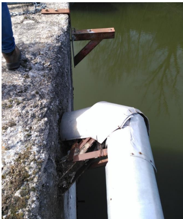
Figura 2.- Detalle de la tubería embebida en el hormigón del azud
