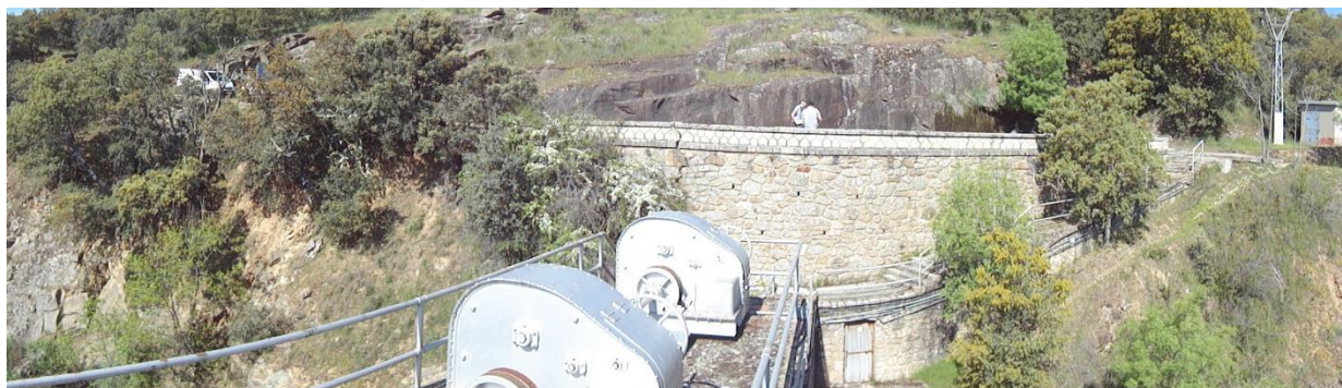
Figura 32.- Panorámica de la zona de plataforma y del muro de mampostería, en el estribo derecho del azud de "El Tenebroso".
