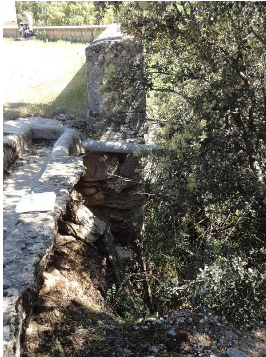
Figura 34.- Fotografía general de la sección transversal del muro de mampostería y pretil.
