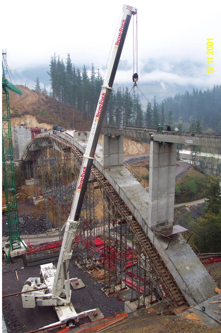
Figura 37.- Fotografía ejemplo de reparto de carga de las patas de la grúa en placas de aprox. 2x2 m.
