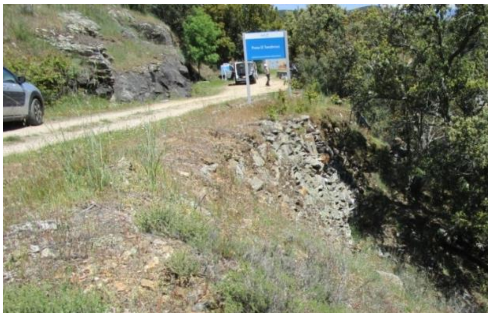
Figura 56.- Fotografía general del camino, con el relleno de bloques de ortoneises bajo el.
