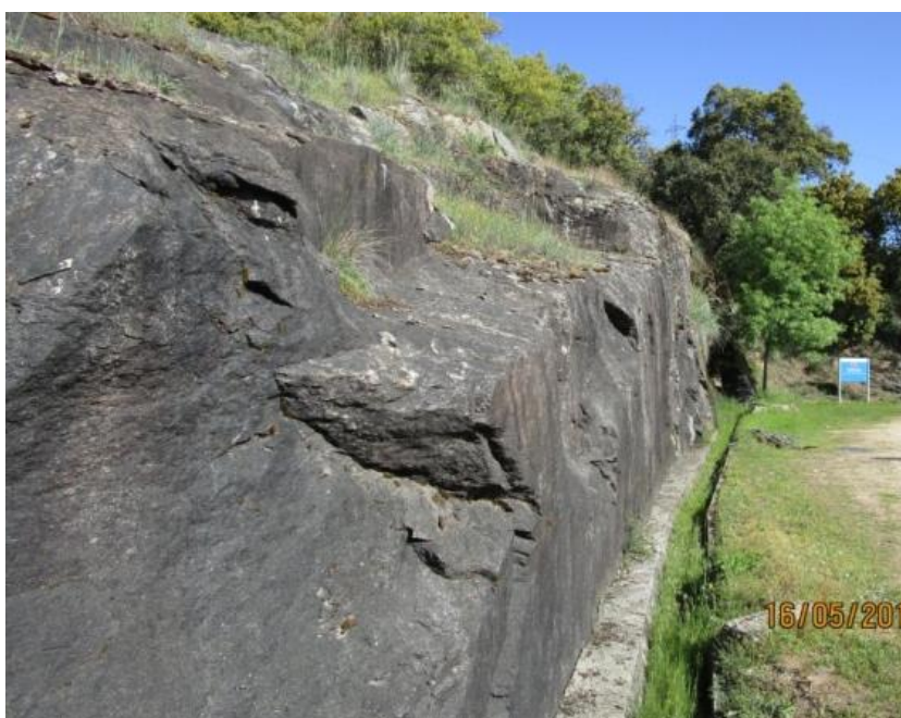
Figura 49.- Fotografía general del talud superior de la plataforma, excavado en ortogneises.
