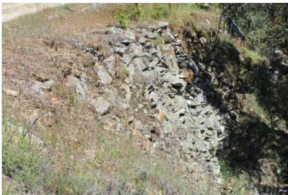
Figura 57.- Detalle del relleno de bloques de ortoneises bajo el camino.
