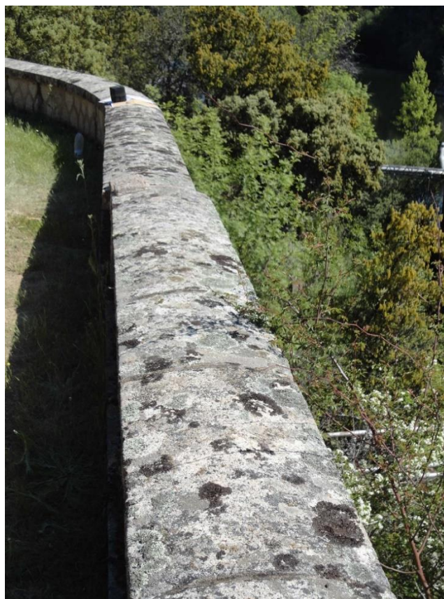
Figura 40.- Fotografía de la grieta nº 1, cambio de alineación en el pretil.
