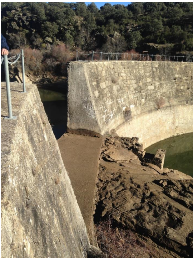
Figura 18.- Escotadura del azud sin agua
